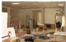
Início das melhorias no auditório
